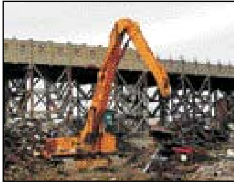
شكل (١٠-١٧) مغناطيس كهربائي ضخم يجذب الفلزات
