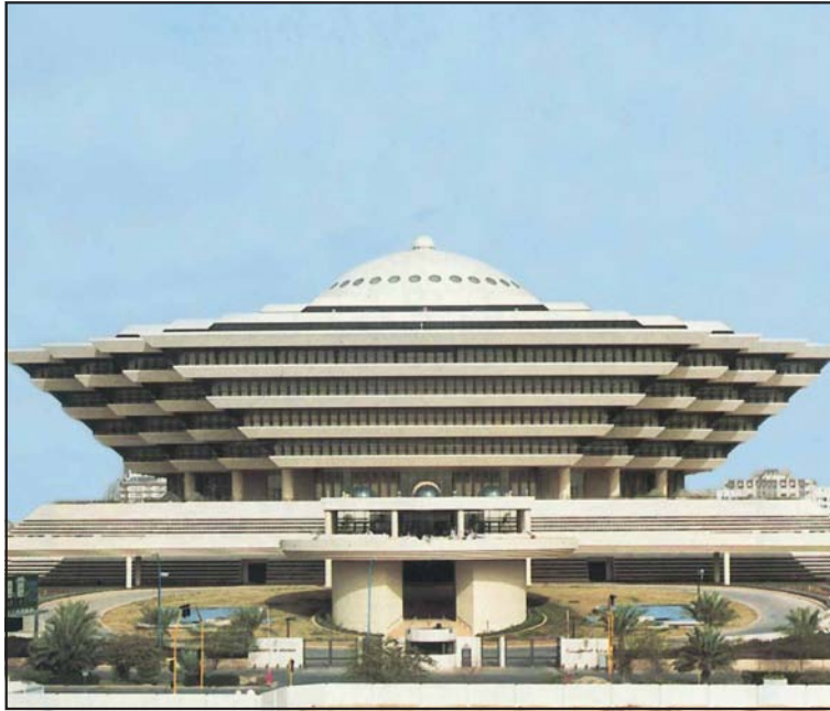
مبنى وزارة الداخلية
